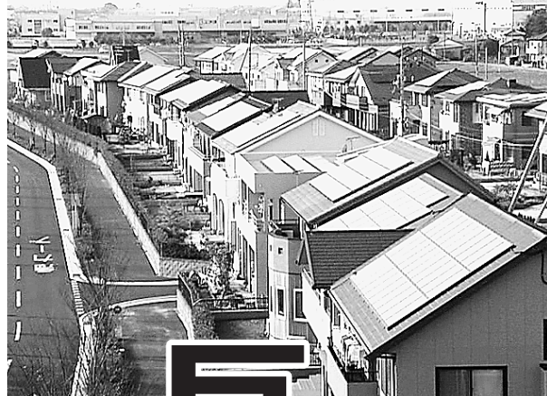
群馬県太田市のソーラータウン「バルタウン城西の杜(もり)」。太陽電池パネルが設置された553軒の家が立ち並ぶ
